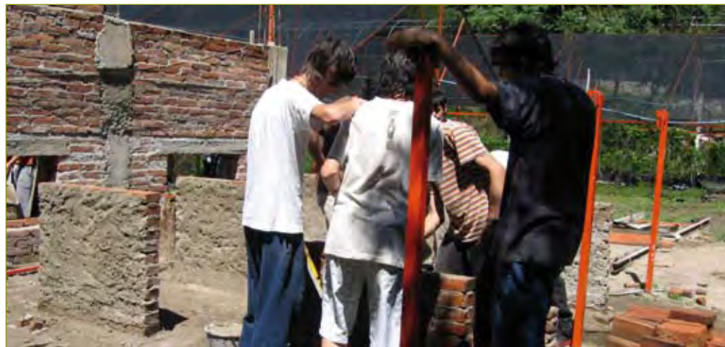
Alumnos del Instituto Técnico Maestro Alfredo Bravo, encargados de la construcción del invernadero.
